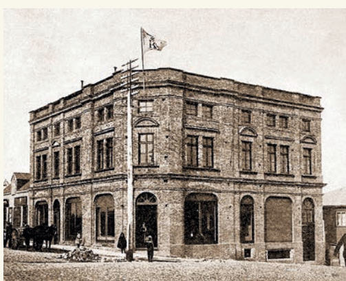
Edificio calle Errázuriz con 21 de Mayo, en cuya planta superior funciona el Club Croata.
