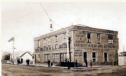
Casa de comercio de L. L. Jacobs. Actual edificio Victoria.
